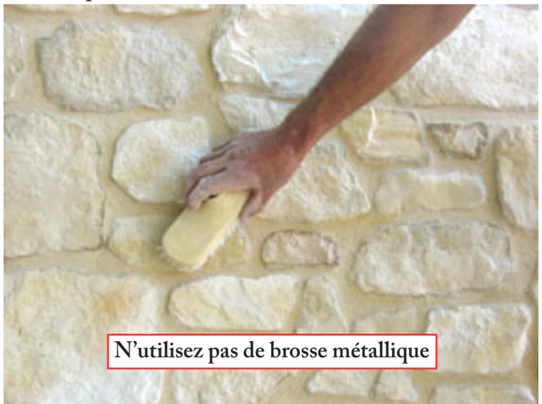
Brossez énergiquement la surface des pierres avec une brosse sèche. Nettoyez le mortier sur les pierres dans les heures qui suivent, n'attendez pas le lendemain.
