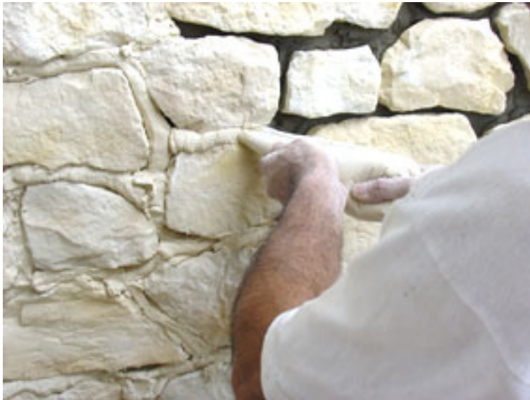
Pressez le pochoir pour faire sortir le mortier dans les joints.
