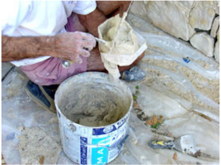
Coupez l'embout du pochoir et remplissez le de mortier joint.
