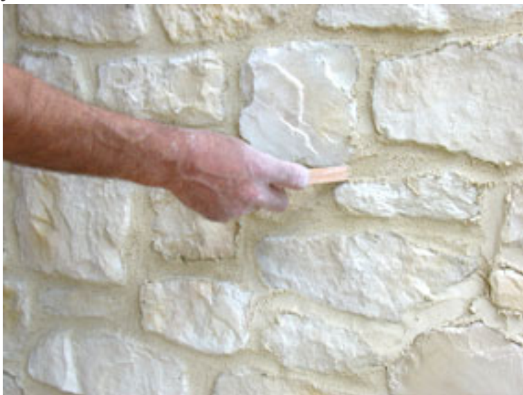
Lorsque le mortier devient ferme, utilisez une raclette en bois ou en plastique pour racler les excès de mortier et donner l'aspect de finition des joints.
