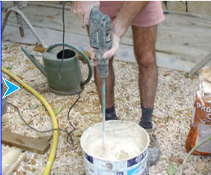
Malaxez au mélangeur mécanique le mortier joint jusqu'à obtention d'une pâte homogène.
